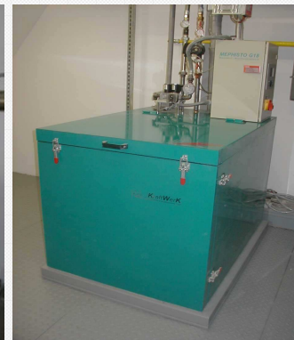
CHP Bremer Höhe 18 kW el / 42 kW th
