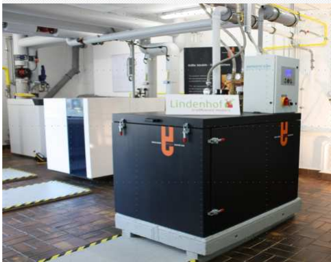
CHP Lindenhof 20 kW el / 46 kW th
