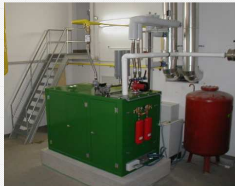
CHP Pulvermühle 50 kW el / 95 kW th
